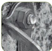
• Punto de anclaje con tornillo de expansión para hormigón. **CE EN 795 A**
